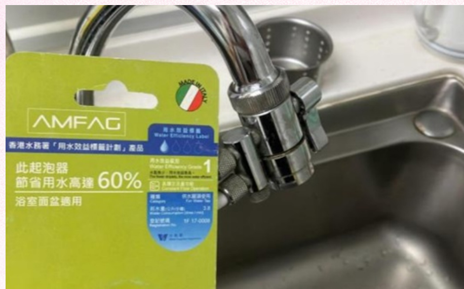
Water saving aerator 節水型起泡器
