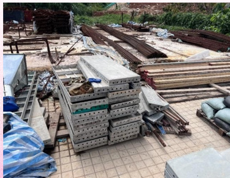
Use of aluminum formwork for concrete formation 使用鋁模板進行混凝土成型
