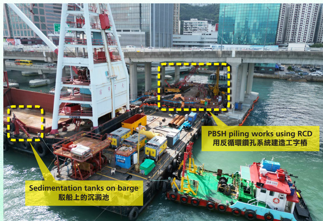
Reverse circulation drilling method for marine piling works 使用反循環鑽孔方法在海港建造樁柱
