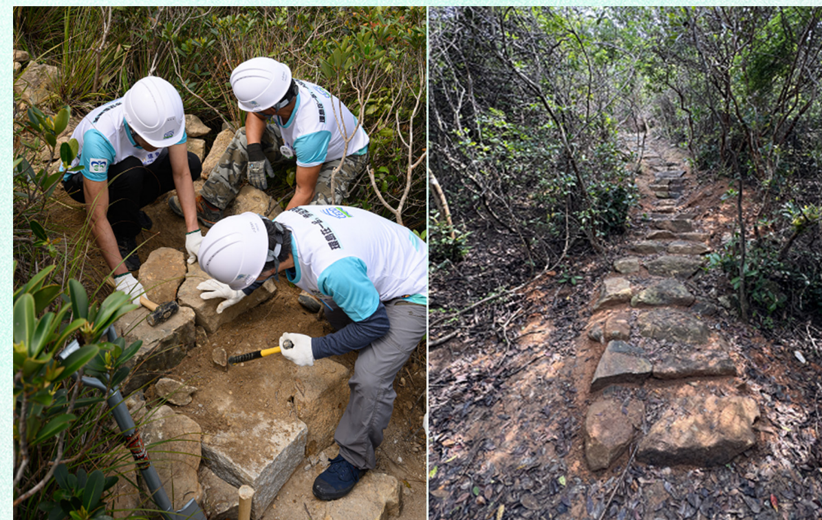
Hiking trail built using handmade trail method 採用手作步道方式建造的行山徑
