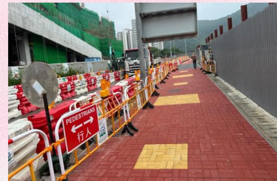
Use of recycled aggregates in concrete pavers (eco-pavers) for footpaths 在行人路採用加入循環再造物料的混凝土鋪路磚（環保地磚）
